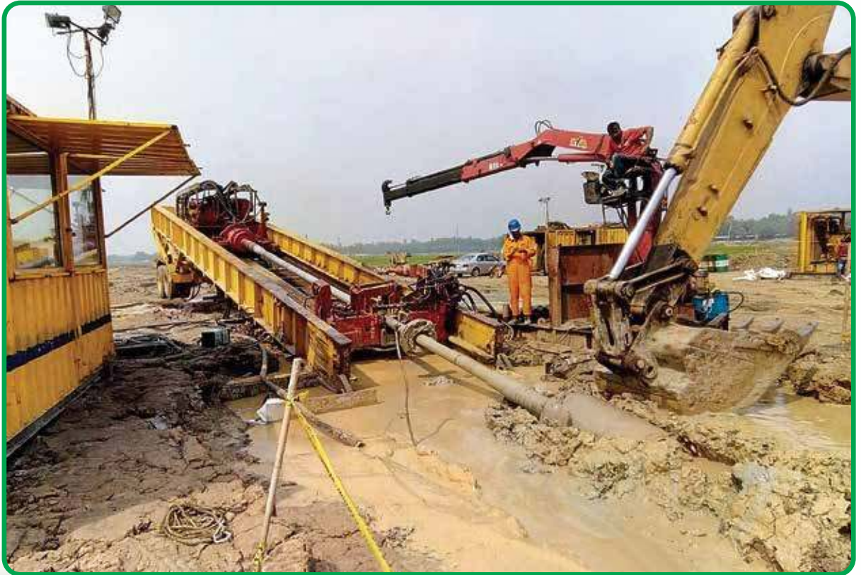
ধনুয়া-নলকা পাইপলাইন নির্মাণ প্রকল্পের এইচডিডি পদ্ধতিতে টংকি-১ নদী অতিক্রমের কার্যক্রম
