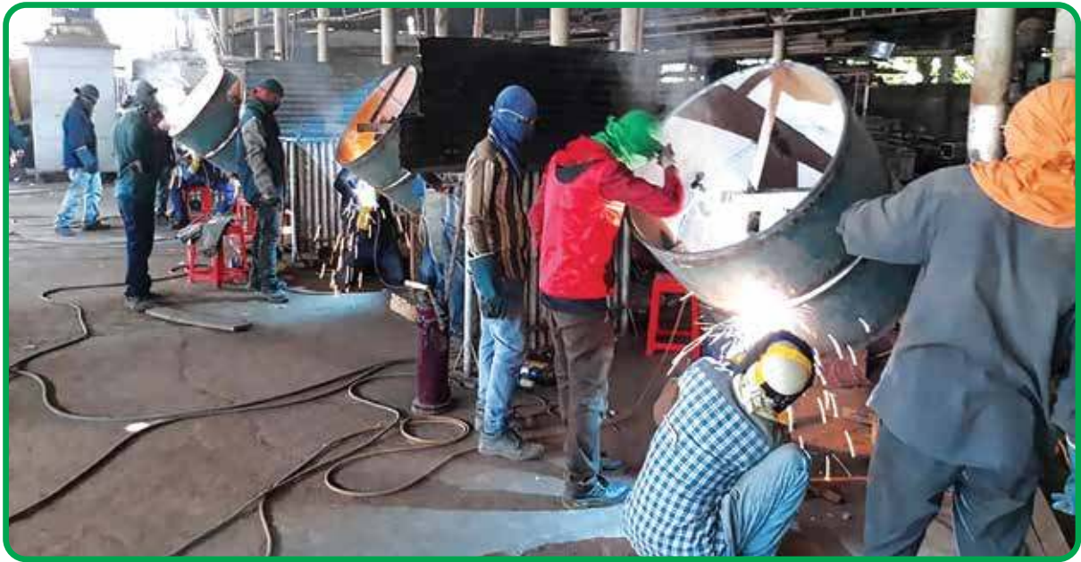
চট্টগ্রাম-ফেনী-বাখরাবাদ প্রকল্পের ওয়েল্ডার টেস্টিং কার্যক্রম
