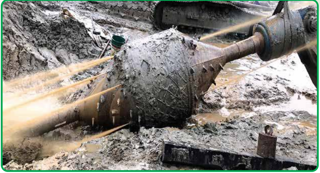
আনোয়ারা-ফৌজদারহাট প্রকল্পের এইচডিডি পদ্ধতিতে কর্ণফুলী নদী অতিক্রমন কাজের পাইপ পুলিং এর প্রস্তুতিমূলক কার্যক্রম
